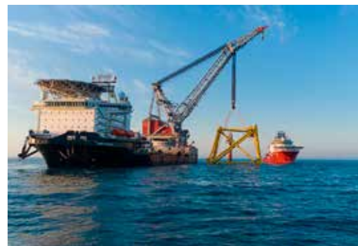
Caisson installasjon, Yme-feltet. Kunde: Repsol.
