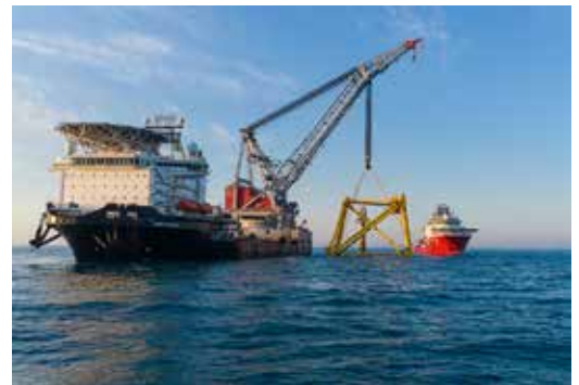
Caisson installasjon, Yme-feltet. Kunde: Repsol.
