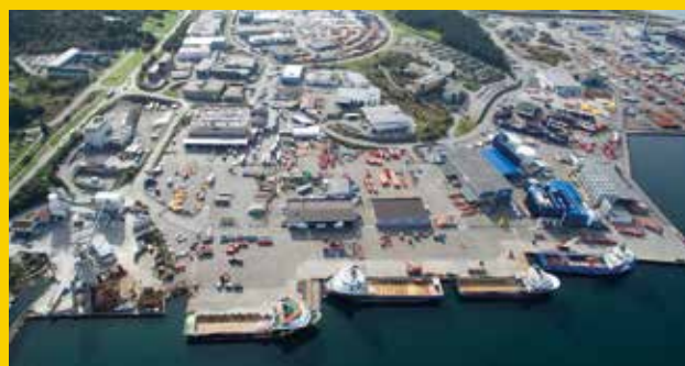
Risavika – Offshore Terminal Kontorlokaler og kaianlegg tilgjengelig
