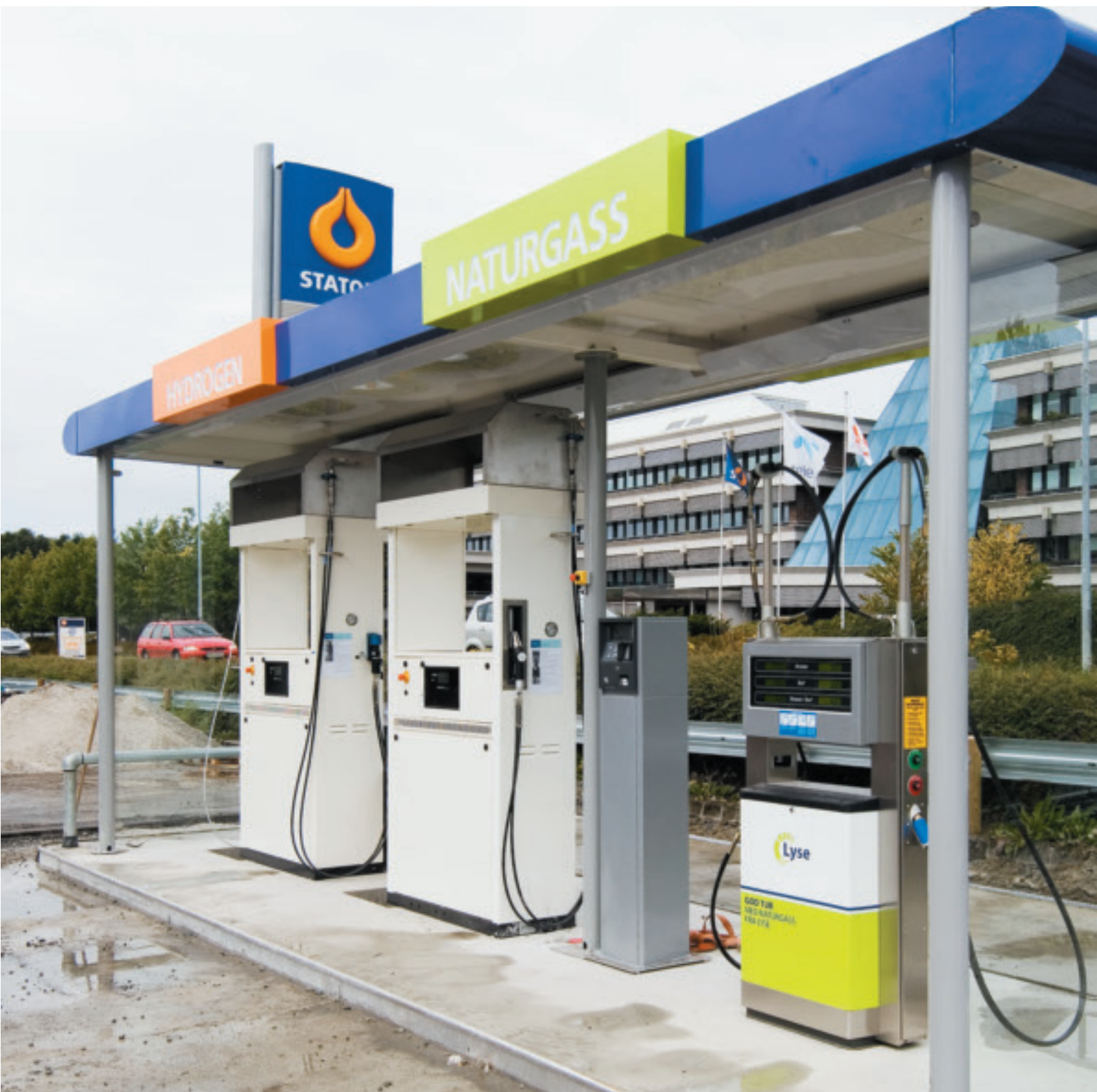
Den 23 august 2006 åpnet Norges første hydrogen- fyllestasjon. Stasjonen er en integrert del av Statoilstasjonen på Forus like ved Statoils hovedkontor.
